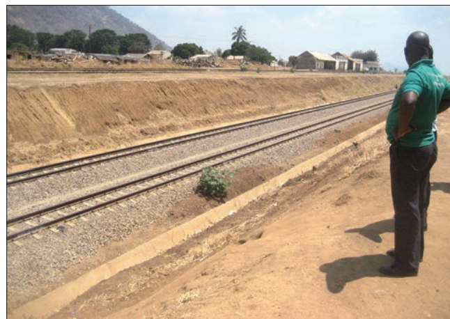
石炭を積んだ貨車を通るナカラ鉄道の線路は3mほど掘って設置され、陸橋がないために長距離にわたって通行を妨げている 2016年9月 ナンプラー州 撮影：渡辺 直子
